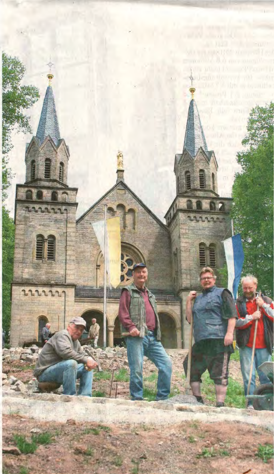
Fleißige Hände: Vor dem Käppele entsteht die neue Aussichtsplattform.
